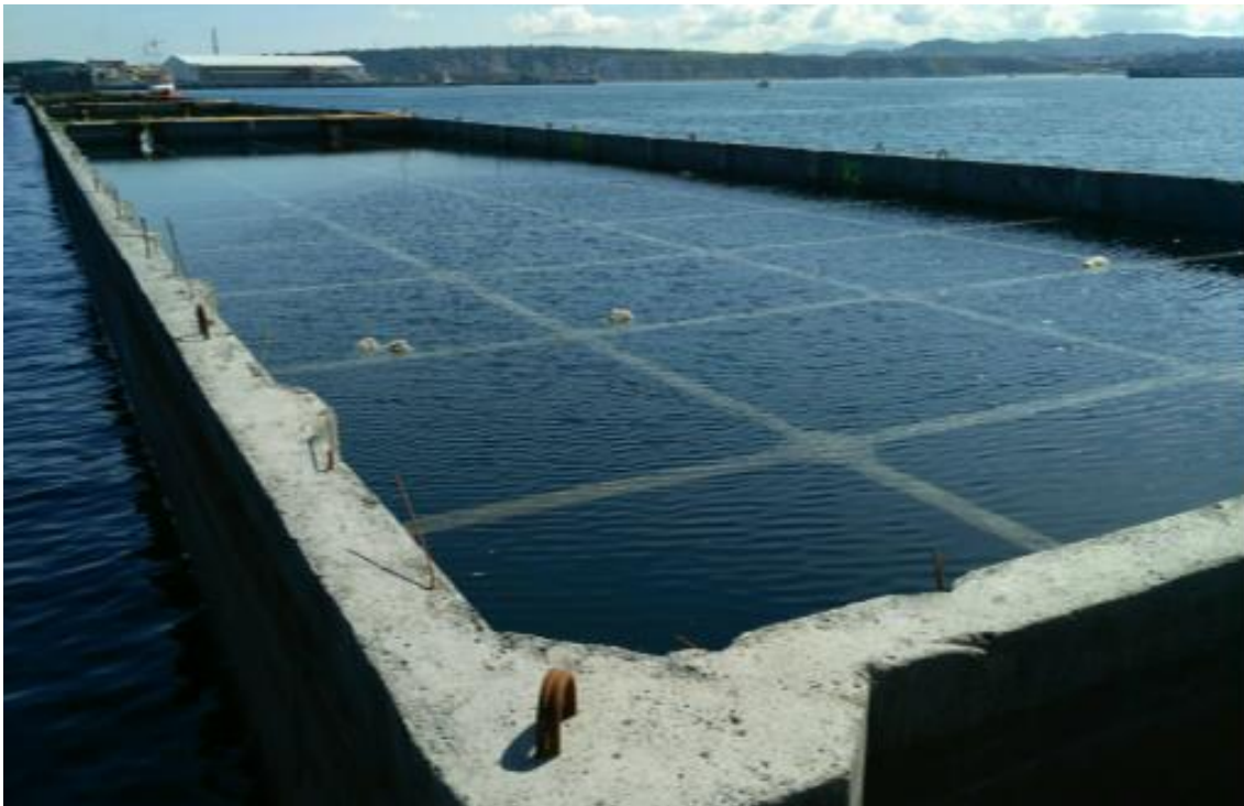
Figura 11. Cajones y celdas del espigón central durante la visita del día 5 de junio de 2017.
