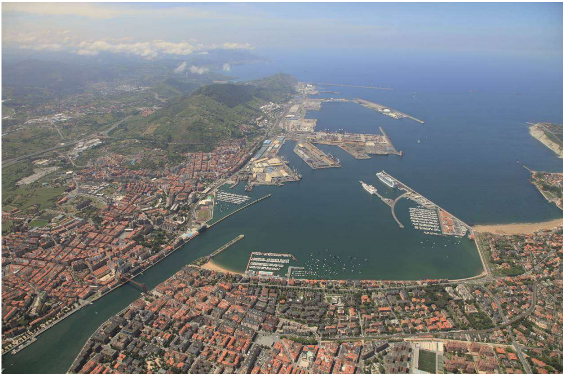
Figura 1. Puerto de Bilbao y entorno (vista desde Las Arenas). Situación preoperacional
